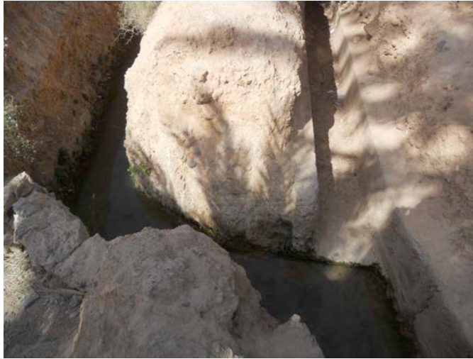
figure 2. Canal bétonné à Ighrem Akdim, Tinghir (Photo Mahdane 2013)
